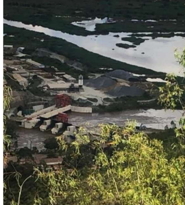
Rusumo HPP site (Dam)
